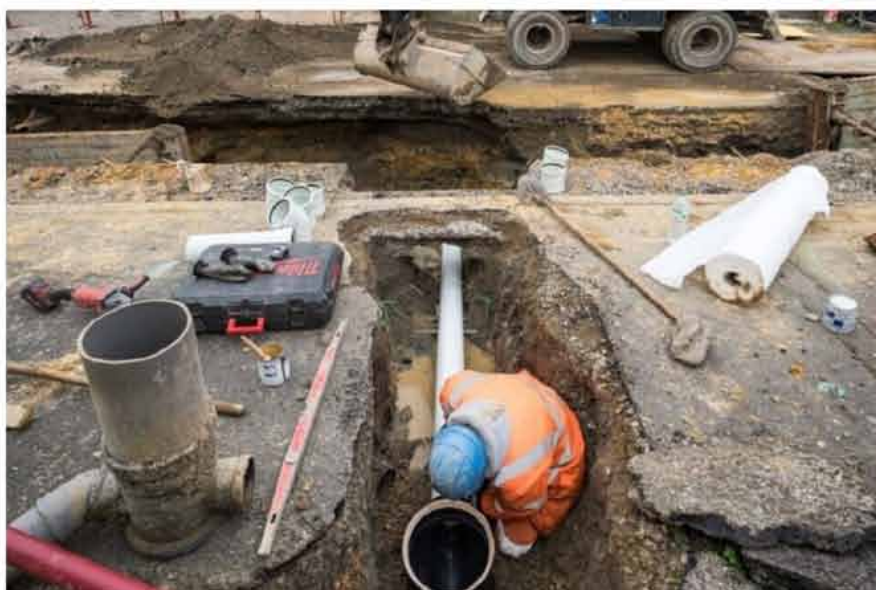
Un nouveau dispositif de traitement des eaux usées a été inauguré à Brixey-aux-Chanoines, ce mardi 9 avril.
