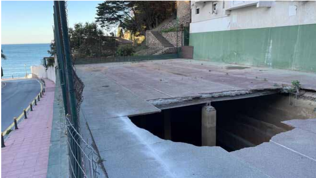
La Mancomunidad de Municipios de la Costa reparará el depósito de Cotobro / G.H.
