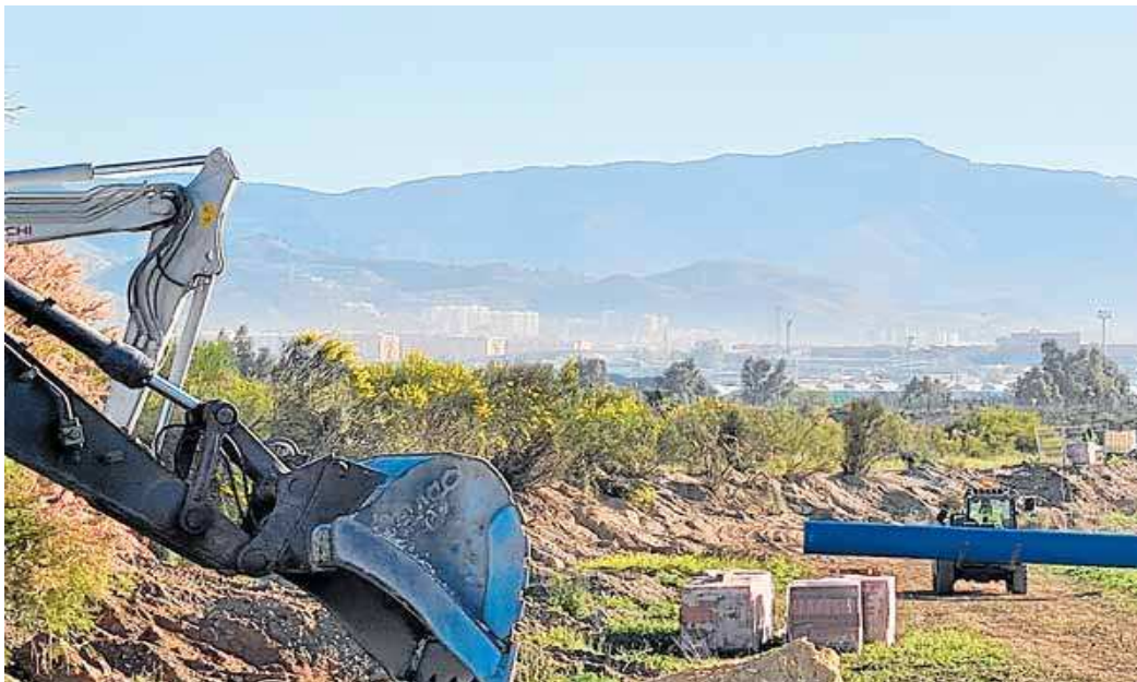
Maquinaria trabaja en el Camino del Puente del Rey, en suelo alhaurino, con la vista de Málaga al fondo. J. R. C.
